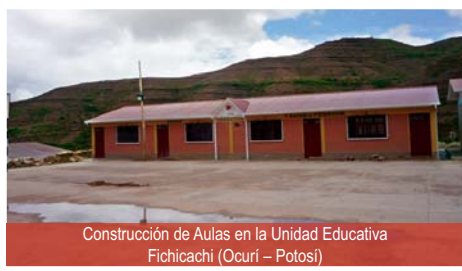
Construcción de Aulas en la Unidad Educativa Fichicachi (Ocurí – Potosí)
