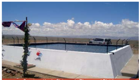
Construcción de Sistema de Riego en el Distrito 10 de la Ciudad de El Alto (El Alto – La Paz)
